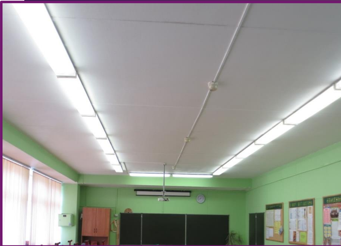
Проведен ремонт потолка
